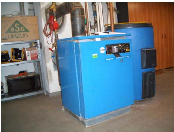
Abb.1: Für Energieeinsparcontracting geeignet
