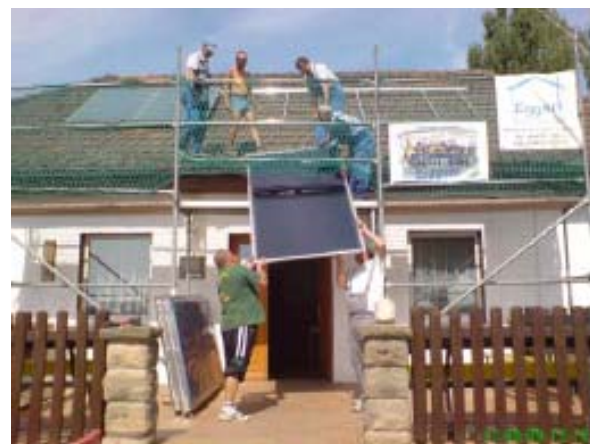
Abb. 1: Montage einer Solaranlage
