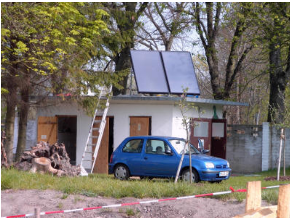
Abb. 2: Die Mini-Solaranlage auf dem Duschhaus (Quelle: Lederhexen e.V.)
