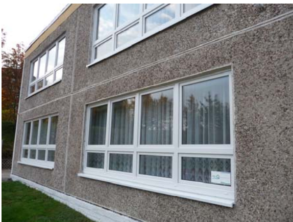
Abb.1: Neue Fenster sparen Energie
