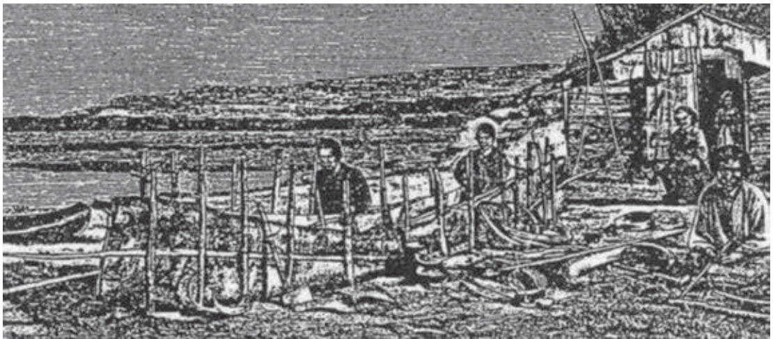
Abb.: Indianer beim Bau eines Kanus
