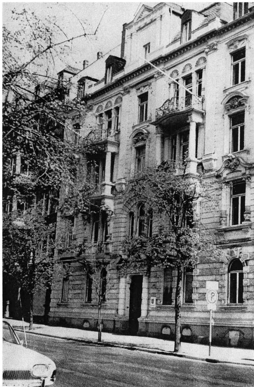
Abb. 37 Provisorisches Regierungsgebäude 1945 – 1966, Wiesbaden, Taunusstraße 51
